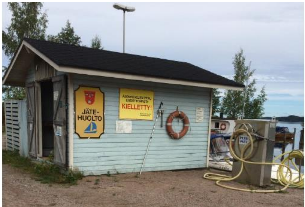
Kuva: Messilän jätteen vastaanottorakennus
